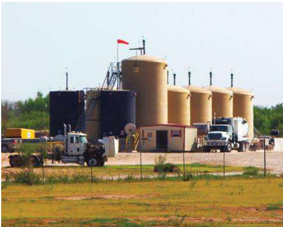
Figura 18 - Central de destinação de flowback por poços de injeção, Texas, Estados Unidos.
