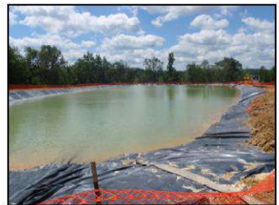
Figura 10 - Reservatório de água, revestida, para atividades de perfuração e posteriormente fraturamento hidráulico.
